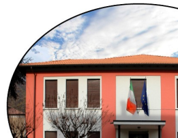
Primaria di Cogozzo Via Tolotti
